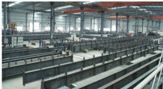
生产线 PRODUCTION LINE
